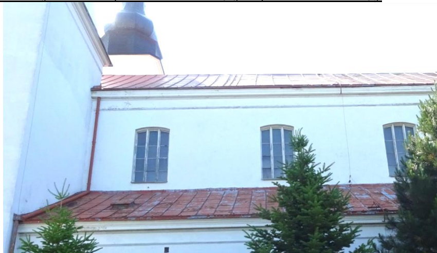
Fot.17 Skorodowane pokrycie dachu nad nawą boczną .Liczne przecieki na konstrukcję więźby dachowej
