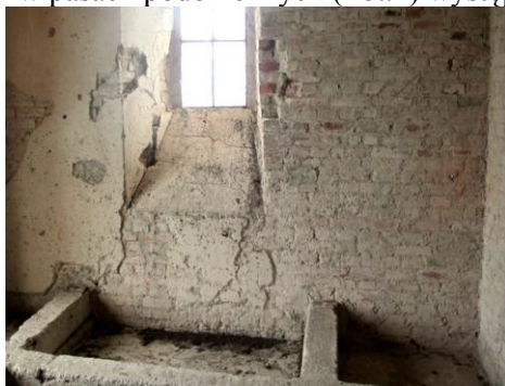
Fot.1 Uszkodzona struktura tynku i muru
