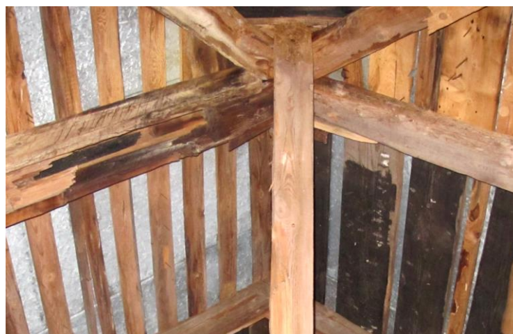
Fot.16 Nad nawą główną . Uszkodzenie węzła kalenicowego przez Grzyb domowy biały ( Poria vaporaria ) PRÓBKA NR1. Węzeł wymaga wzmocnienia .Deski impregnowane lepikiem(?)
