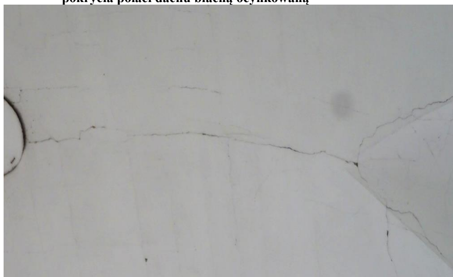
Fot.5 Pęknięcie tynku na łuku sklepienia nawy głównej
