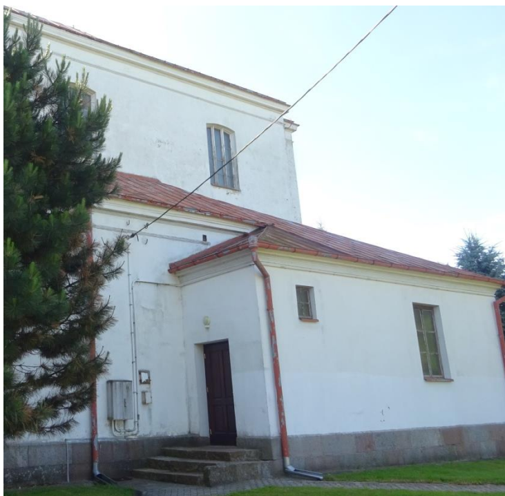
Fot.21 Elewacja . Tynk przy skrzynce elektr. z nalotami glonów (algae), i „odparzeniami” wywołanymi hydrolizacją soli budowlanych Przelewanie wód deszczowych ponad obróbką blacharską
