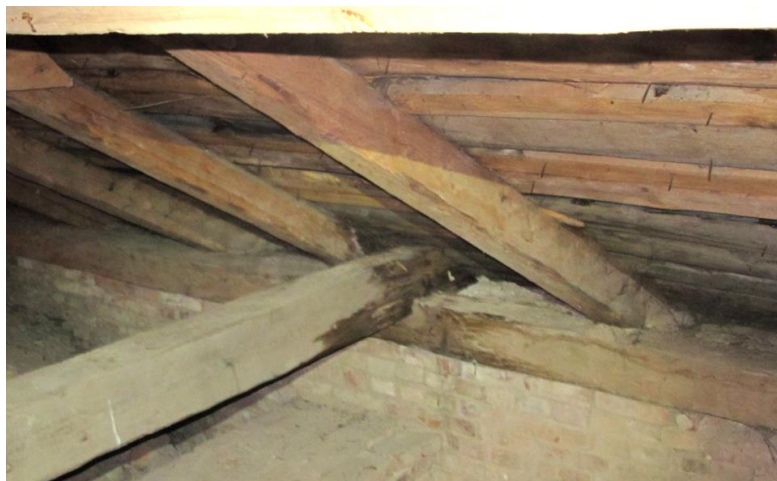
Fot.14 Oparcie belki stropowej na murlacie .Po zacieku widoczny rozwój grzybni Grzyba domowego białego ( Poria vaporaria )
