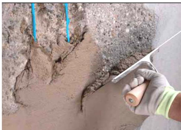
Fot.25 Układanie kielnia zaprawy Planitop400 (Mapei)
