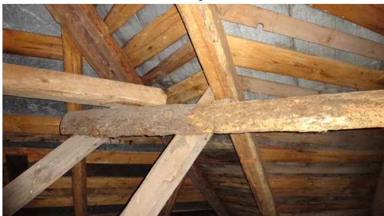
Fot.11 Nieokorowana poprzeczka prowizorycznego podparcia konstrukcji z wysypującą się „mączką” drzewną z otworów o średnicy 2-3 mm. Miejsce aktywnego rozwoju Kołatka upartego ( Anobium pernix ) Pobrano PRÓBKĘ NR 5
