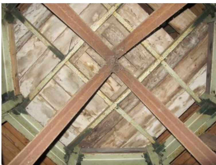
Fot.5 Elementy stalowe konstrukcji wieży dzwonnej
