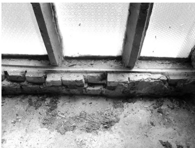
Fot.3 Ubytki cegieł w pasie podokiennym muru
