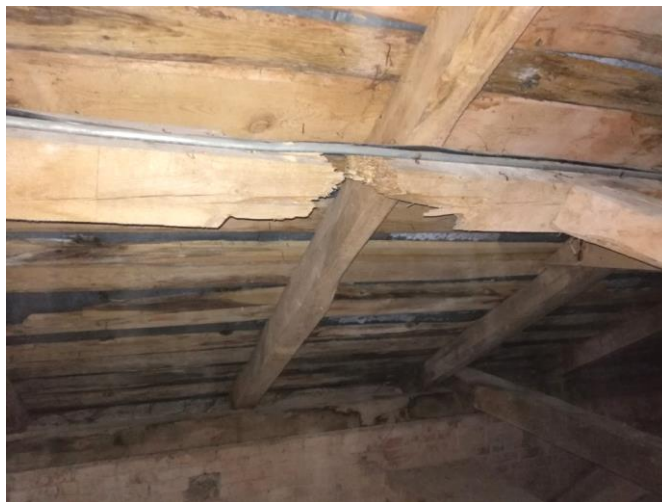
Fot.26 Ubytek płatwi górnej podtrzymującą krokiew
