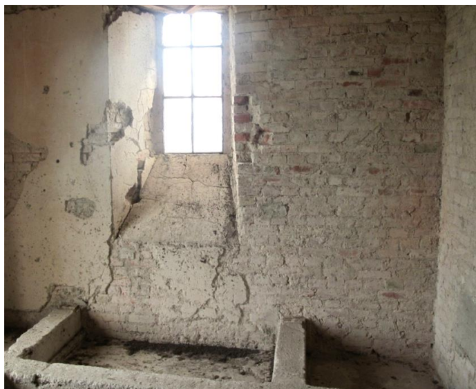
Fot.2 Uszkodzona struktura tynku i muru w wieży dzwonnej
