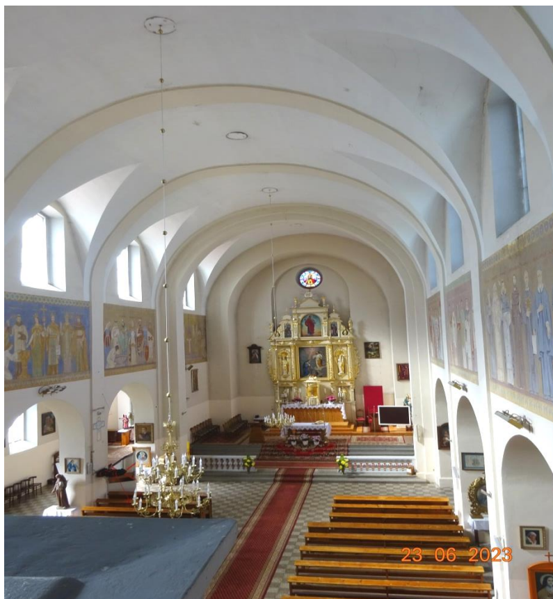
Fot.1 Wnętrze kościoła w kierunku ołtarza głównego . Dwa rzędy kolumn murowanych podpierających sklepienia kolebkowego
