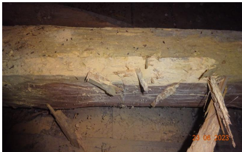
Fot. 4 Belka płatwi dolnej . Uszkodzenia przez Spuszczeła pospolitego ( Hylotrupes bajulus ) Pobrano PRÓBKĘ NR 4
