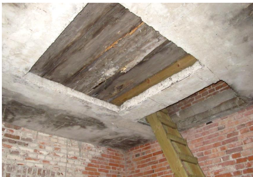
Fot.7 Przykrycie zagrzybionymi deskami otworu w stropie wieży Tu: Grzyb domowy biały ( Poria vaporaria ) PROBKA NR 1
