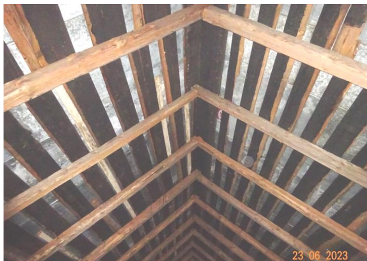
Fot.8 Uszkodzona przez owady –szkodniki drewna budowlanego konstrukcja więźby dachowej nad nawą główną. Stan aktywnego żerowania w części bielastej (zewnątrznej) drewna. Widoczna wysypująca się z kanałów wylotowych owadów mączka drzewna ( Kołatek uparty )
