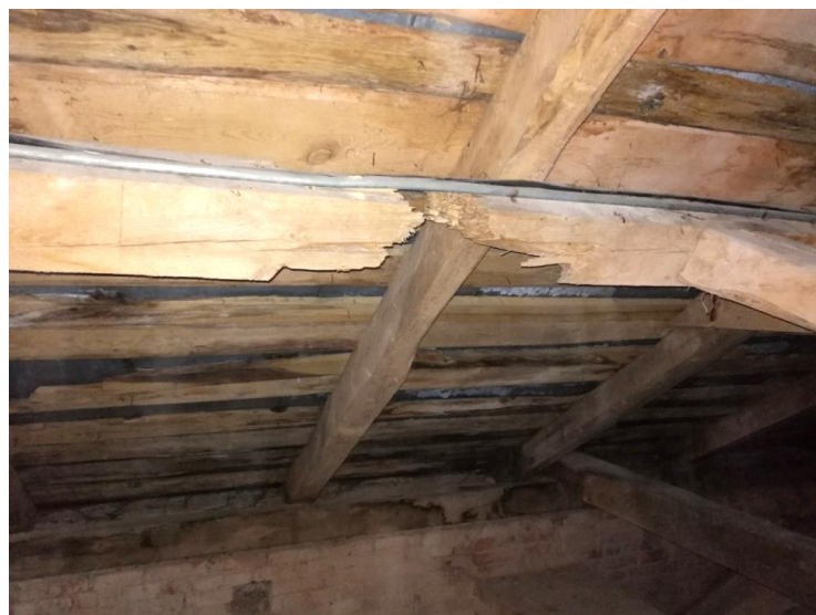
Fot.15 „Urwany”fragment płatwi górnej więzby nad nawą główną
