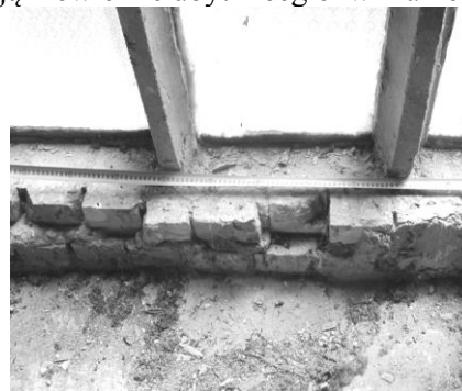
Fot.2 Uszkodzony pas podokienny.
