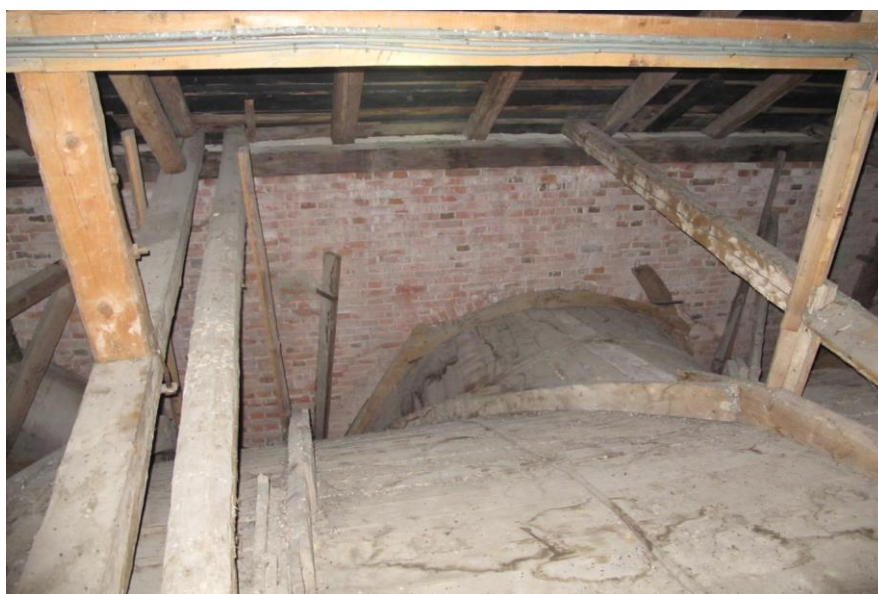
Fot.4 Podwieszenie krążyn stropu kolebkowego .Na deskowaniu stropu kolebkowego widoczne plamy po zacieku z nieszczelnego pokrycia połaci dachu blachą ocynkową
