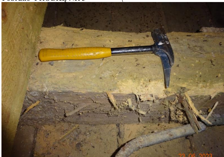
Fot.12 Uszkodzona przez korozję biologiczną belka wieszara
