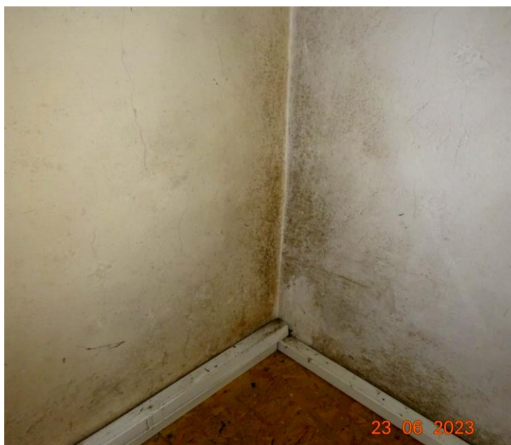
Fot.20 Pleśń czarna ( Aspergillus niger ) w narożniku ścian chóru, naloty powstałe z braku właściwej wentylacji .PRÓBKA Nr3
