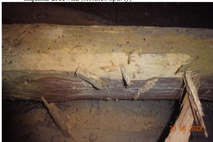
Fot. 9 Belka płatwi dolnej . Uszkodzenia przez Spuszczela pospolitego ( Hylotrupes bajulus ) Pobrano PRÓBKĘ NR 4
