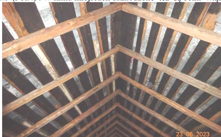
Fot.3 Uszkodzona przez owady – szkodniki drewna budowlanego konstrukcja więźby dachowej nad nawą główną. Stan aktywnego żerowania w części bielastej (zewnątrznej) drewna. Widoczna wysypująca się z kanałów wylotowych owadów mączka drzewna (owad - Kołatek uparty)
